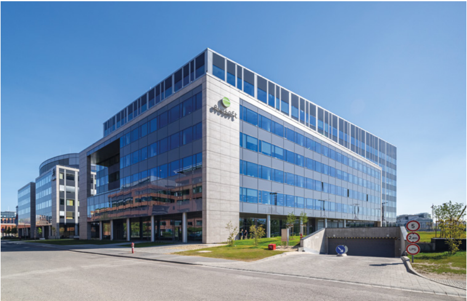
Az épület sarkain megjelenő tömbök keretei alumínium tartószerkezetre rögzített, átszellőztetett, kőhatású, nagytáblás homlokzatburkolati elemek
